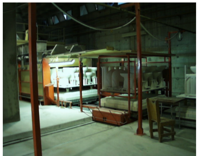
Figura 21 -Exemplo de forno túnel de queima directa
