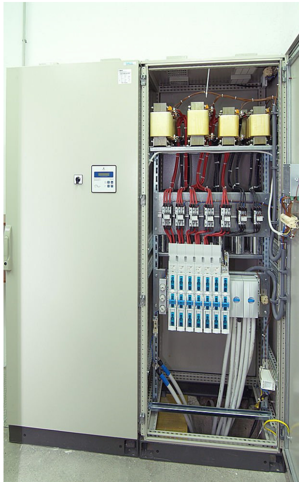
Figura 47 – Exemplo de uma bateria de condensadores [www.directindustry.es]
