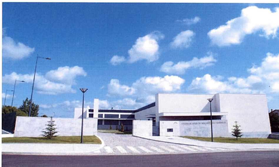
Figura 1 - Instalações do CATAA - Centro de Apoio Tecnológico Agro-Alimentar, onde se encontra sediada a InovCluster
