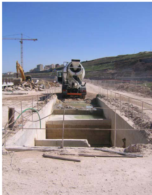
Figura 28 – Reutilização das águas de lavagem das autobetoneiras, por decantação (Fonte: IGAOT)
