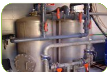
Figura 26 - Filtros em profundidade
